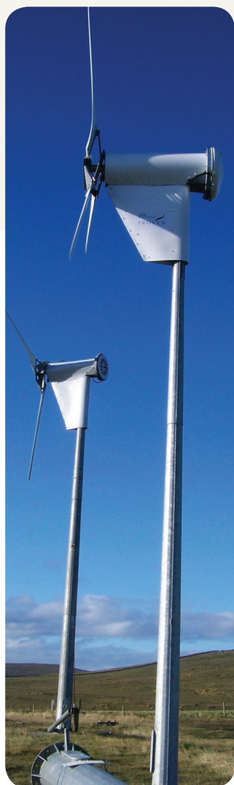
Pieniä tuulimyllyjä Shetlandinsaarten pohjoisimmalla saarella Unstilla. Myllyt tuottavat sähköä ja lämpöä lähitalojen tarpeisiin. Hukkaenergia hyödynnetään pienessä autossa käytettävän vetypolttoaineen valmistuksessa. (Kuva: Margrethe Sørensen, 2006)
