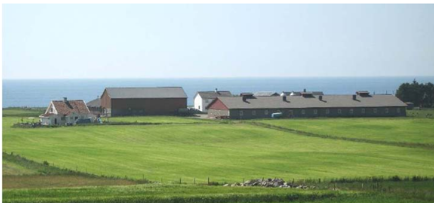
Fig 7.3: Nybygg i tunet. Rogaland. Foto: T. Nærland , og G.Undheim
