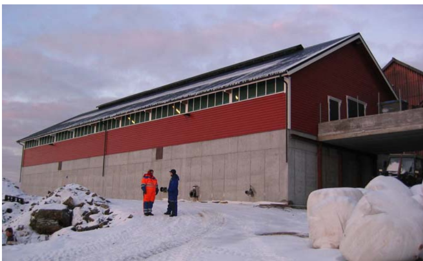
Figur 40: Klassisk norsk konsept i ny drakt. Gjødsellager under hele eller deler av husdyrrommet. Plan og foto: FMLA Hordaland, E. Neerland
