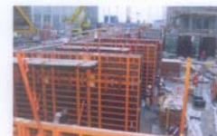
Klar til støbning af de tre første kældervægge med SCC, DR-byen, Segment 3.
