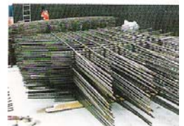
Exempel på monteringsvetsad armeringsbeter.
