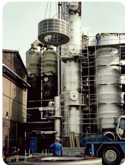
在有色金属冶炼厂安装奥图泰硒过滤器 照片：奥图泰
