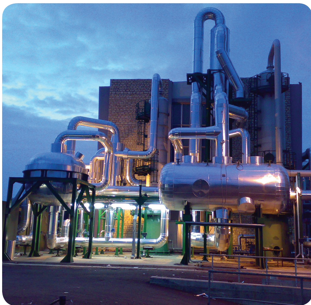
意大利拉尔代雷洛地区一家安装了AMIS的工厂。照片左边的球体是奥图泰硒过滤器。 照片：埃尼电力公司
