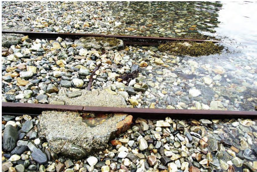
Mynd 3. Skinnararnir í dráttinum eru festir við betongi. Taravaksnir steinar í fjøruni.
