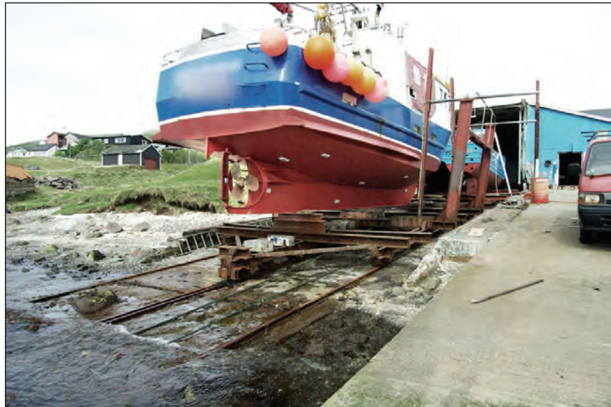
Mynd 34. Sleipistöð F 1: Vognur á skinnarum á betongpalli.
