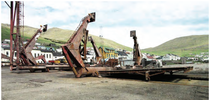
Mynd 45. Vognur á skinnarum á heilstoyptum palli á sleipistöð F3.
