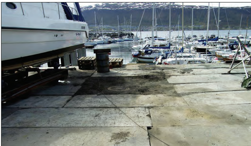
Mynd 12. Stoyptar betongflísar, sum hella oman til savningarbrunn til spulivatn á sleipistöðini N3.
