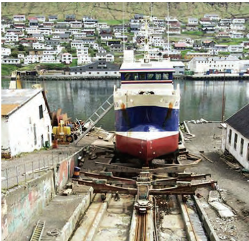
Mynd 43. Vognur á skinnarum í heilstoyptari rennu (betong).
