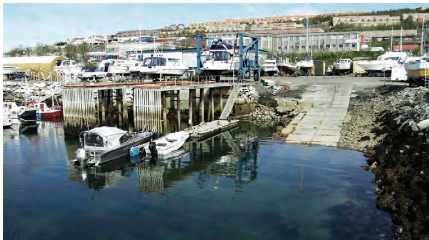
Mynd 10. Sleipistöðin N3 hevur tvær dráttarskipanir; vogn við lyftistroppi, og pall til drátt av vogni við hjólum, drigin av traktori.
