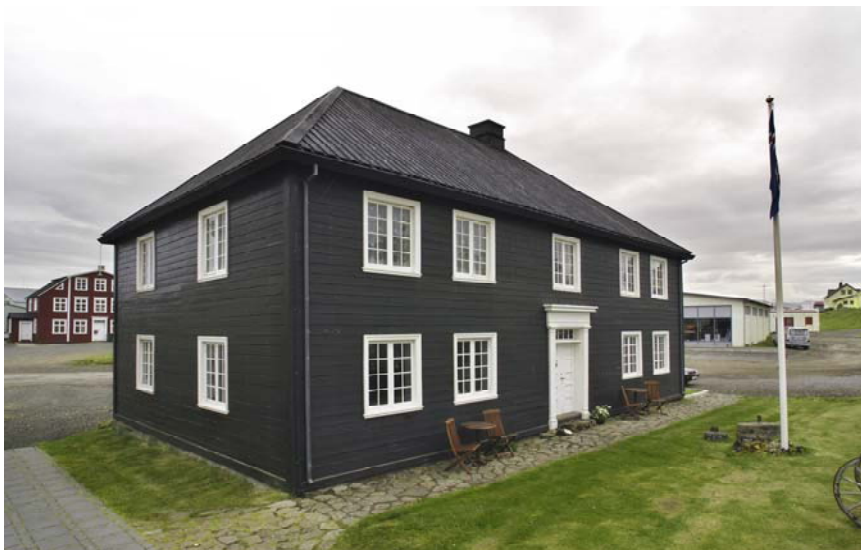
En stor vikt har lagts vid att bevara och reparera gamla hus på Stykkishólmur. Bilden visar ortens äldsta hus, det s.k. “Norska huset”, som flyttades till Island från Arendal i Norge och byggdes år 1832. Huset hyser i dag det regionala muséet för Snæfellsnes och Hnappadals syssel. Foto: Guðmundur Páll Ólafsson.
