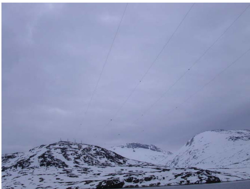
Vanskelig geografi og høj forsyningssikkerhed er omkostningstungt. Transmissionslinje Nuuk
