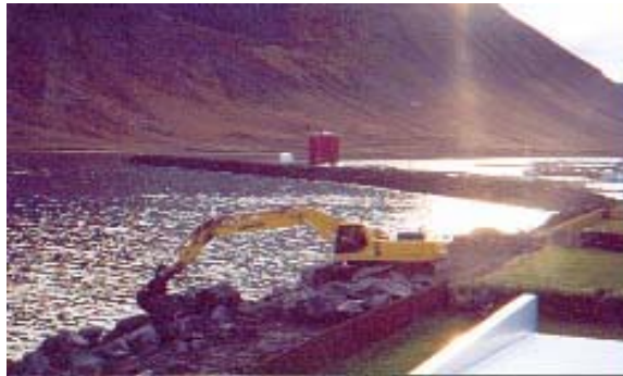
Figur 2. En damm byggs i Ísafjörður kommun
