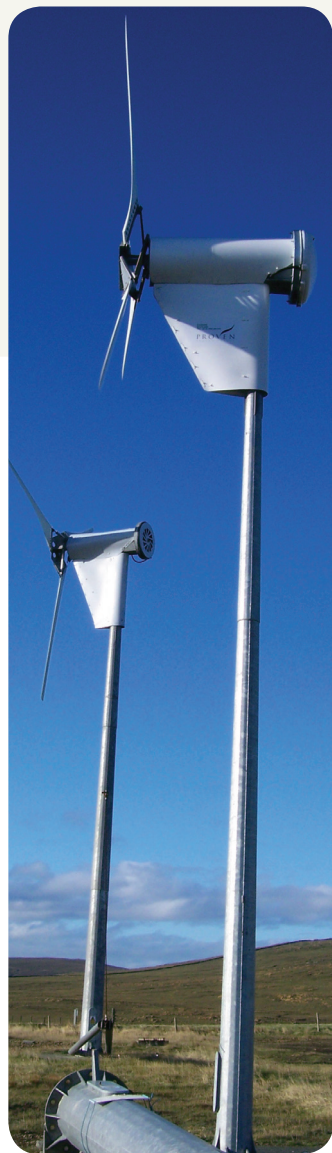
Litlar vindmyllur á Unst, á nyrstu eyinni á Hjaltlandi. Myllurnar sjá húsum í nágrenninu fyrir rafmagn og hita. Umframorkan er nýtt til þess að framleiða vetni sem notað er á lítinn bíl. (Mynd: Margrethe Sørensen, 2006)
