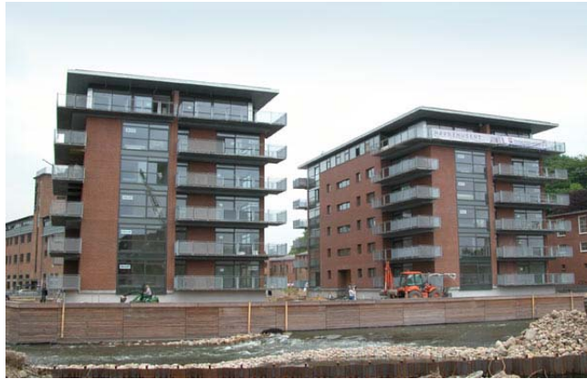
De exklusiva Havenhusene under uppförande
