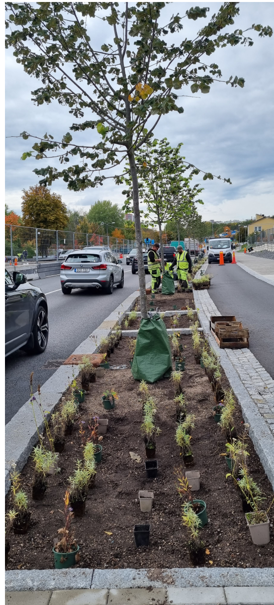
Värmdövägen street transformation, photo by Nacka Municipality
