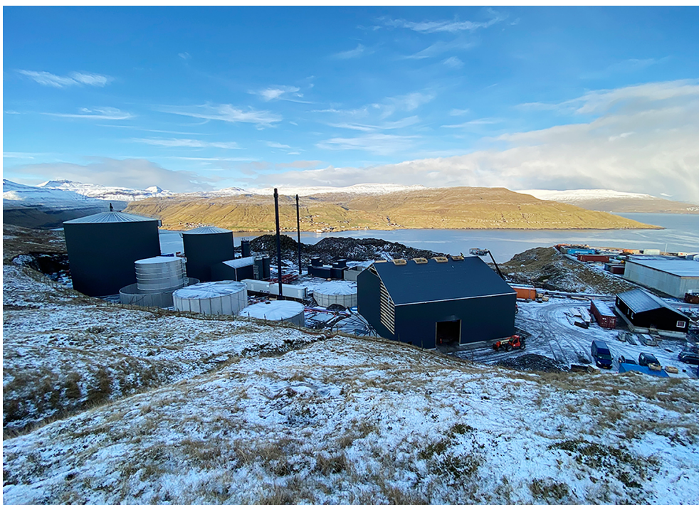
Figur 9: Færka Biogasanlæg i nærheden af Tórshavn under opførelse (Heini Ellingsgaard, SMJ Rådgivende Ingeniører, november 2019).
