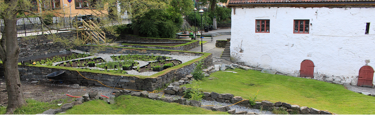
Regnvannsbed og infiltrasjonsbed på Bryggen i Bergen.
