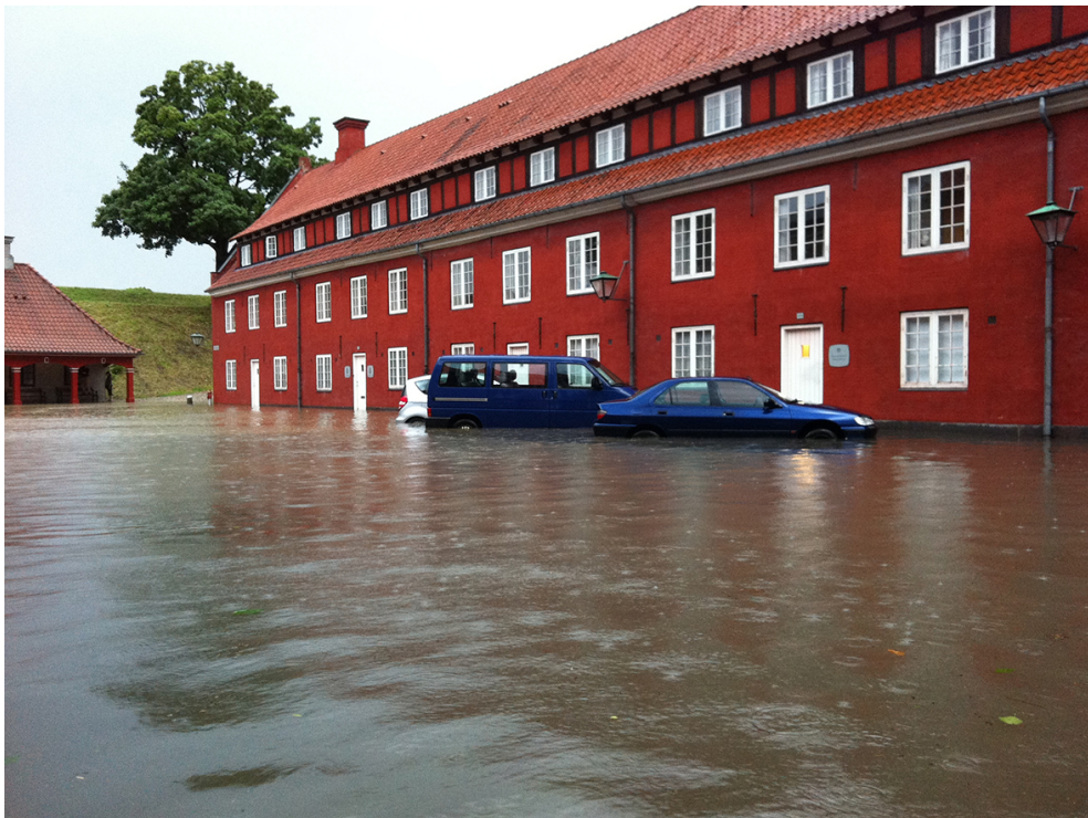
Bilde 4. Kastellet i København fra 1626 er et historisk forsvarsanlegg. Foto tatt under skybruddet 2011. Skybrudd i 2011 og 2014 har resultert i nye løsninger for å håndtere store vannmengder. Foto: avdelingsarkitekt Knuth, Forsvarsministeriets Ejendomsstyrelse.
