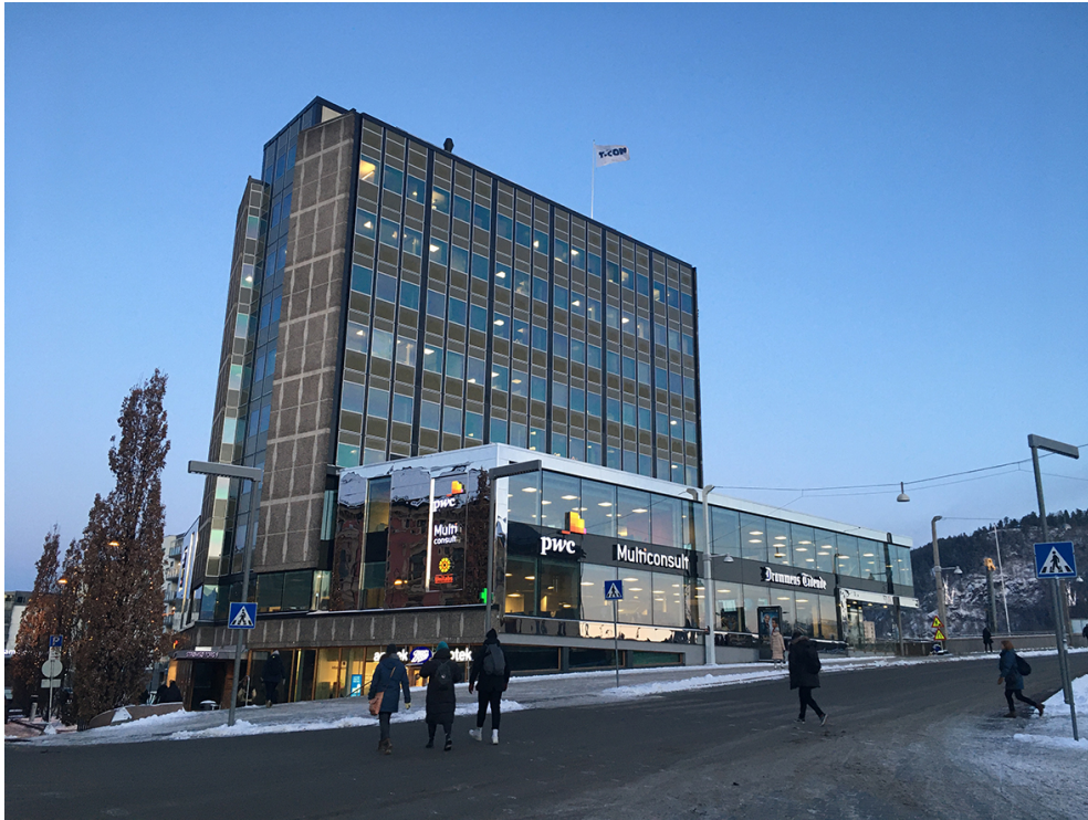
Bilde 15. Strømsø torg 9 i Drammen der man har montert solceller integrert i en bygnings eksisterende fasade. Foto: Aune, Viken fylkeskommune.
