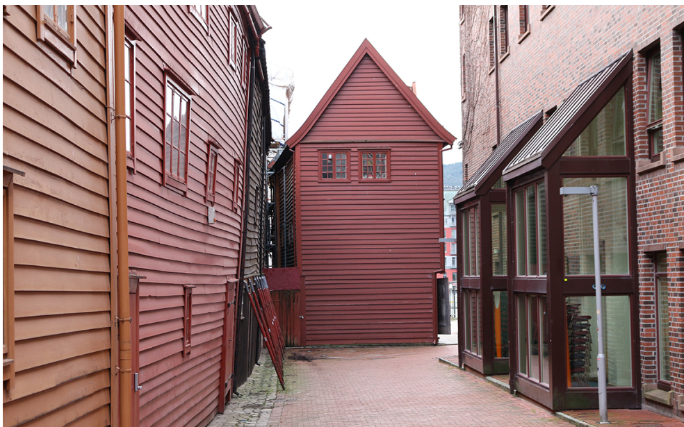
Bilde 19. Bryggen i Bergen, skjeve hus nær spuntvegg ved hotellet. Skjevheter oppstått etter kollaps i kulturlag forårsaket av grunnvannssenkning, da spuntveggen lekket voldsomt. Foto: Dunlop, NIKU.
