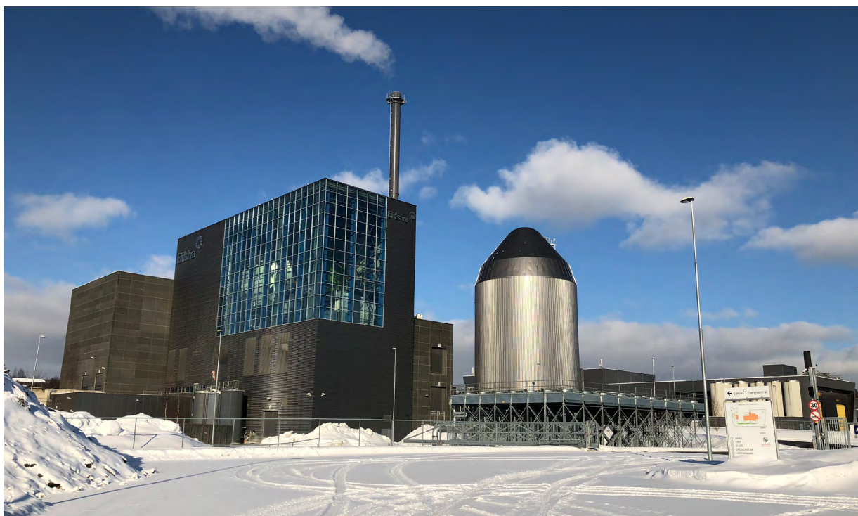
Eidsiva Energisentral Trehøringen Hamar. Källa: Kjell Vaagen
